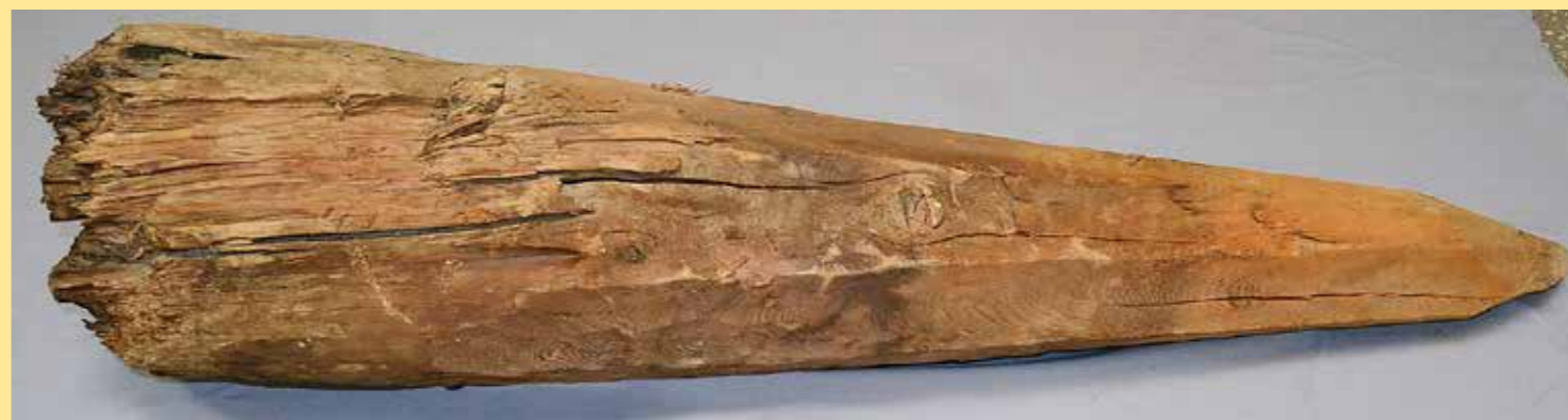
枇杷島小橋の橋杭
